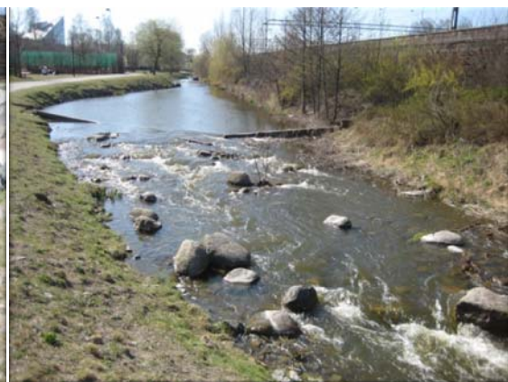
Figur 8. Uppströms leklokalen vid tennisbanorna är en damm anlagd.
