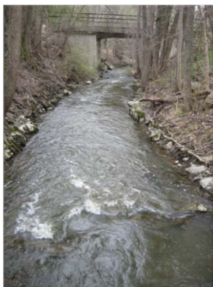
Figur 9. Leklokalen i Verkaån ligger i anslutning till bron vid Verka.
