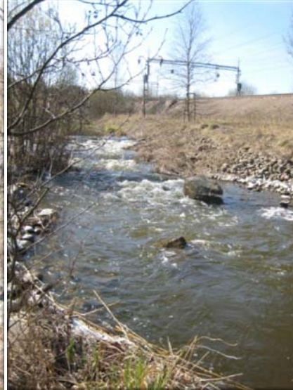
Figur 6. Leklokalen vid Marabou, nedströms järnvägstunneln.
