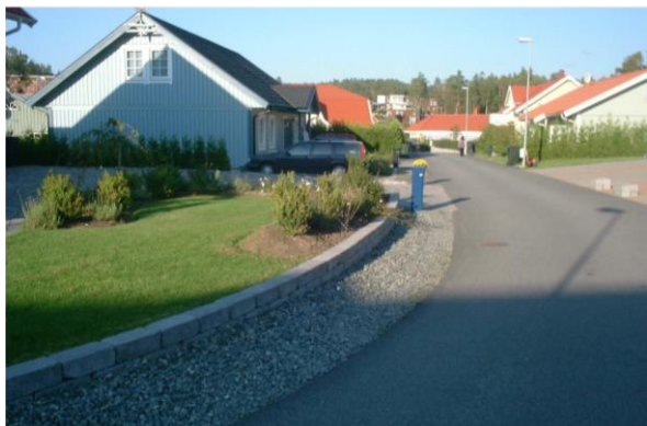
Figur 7. Öppna gräsbevuxna diken och makadamfyllda diken enligt tidigare förslag för Norra Väsjön
