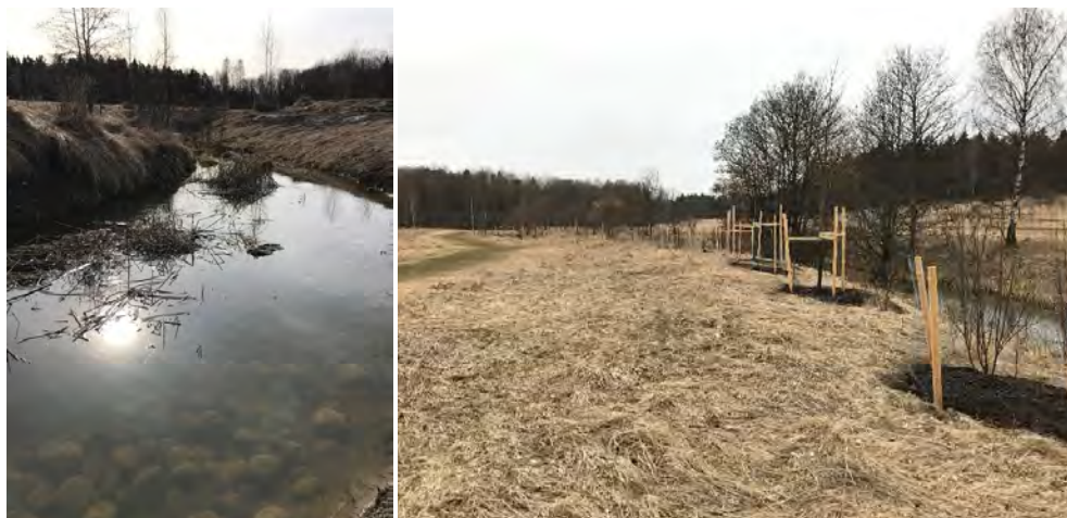
Figur 8. Återställd vattendragssträcka i Sundbyberg. Stenar har lagt i på botten för att öka strukturerna. Träd av hägg, klibbal och sälgbuskar har planterats längs med bäcken för att ge skugga till den annars solbelysta bäcken. Foto: Sundbybergs stad.
