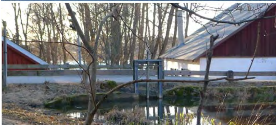
Figur 7 - Landsnora kvarndamm med de reglerbara dammportarna. Övre bild från Google maps 2021, nedre bild från Sollentuna hembygdsförenings hemsida, 2021.
