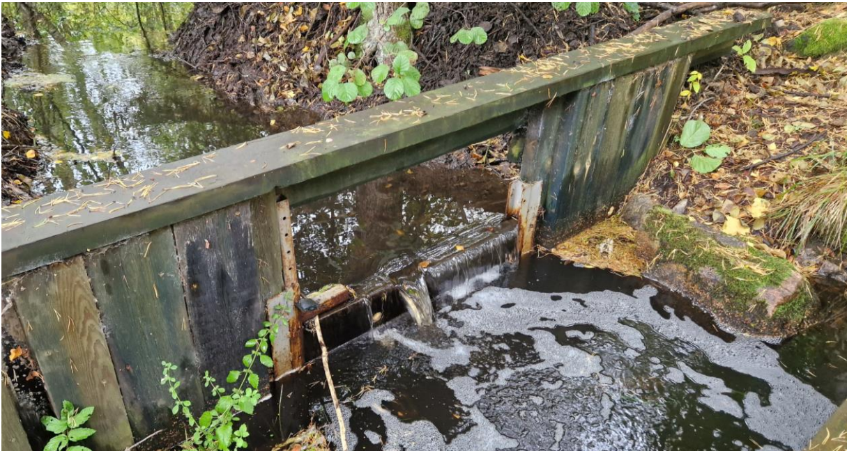
Figur 3-4. Den mindre dammen uppströms Landsnora kvarn.
